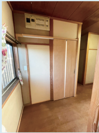
②二つの部屋の間の壁を取り除き一つの部屋に。入口は、写真右側のみにしました。
